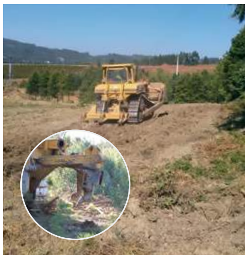
Ripagem para aumentar a profundidade do solo (em pormenor dentes do ríper)
